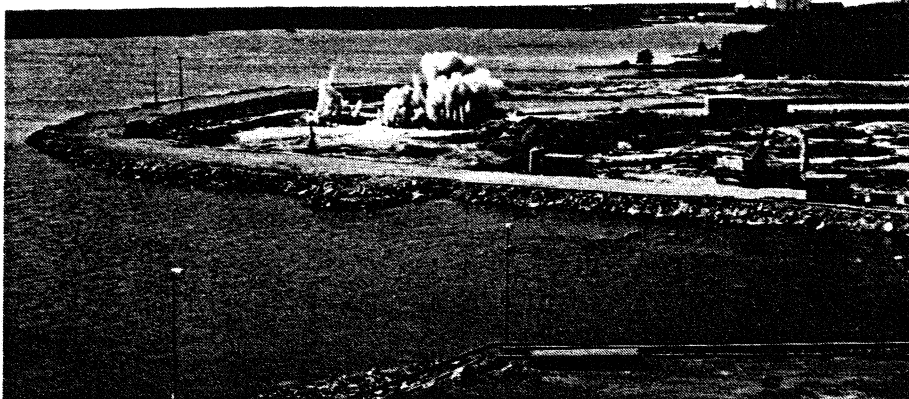
Figur 3.4 SFR - Första sprängskottet för tunnelnedfarten, augusti 1983
